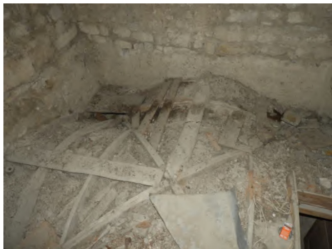
Armatures en bois de la voûte du rez-de-chaussée
