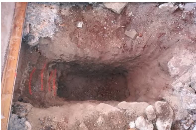
Fouilles des sondages des fondations - 19 janvier 2022 réalisés par Kaéna
