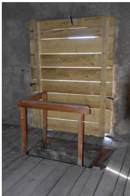
Baie Nord du clocher fermée
