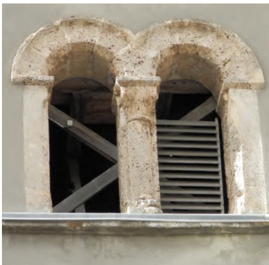
■ Abats sons en état de conservation moyen, traitement nourrissant du bois et remise en peinture nécessaire. Abats son manquant à restituer
