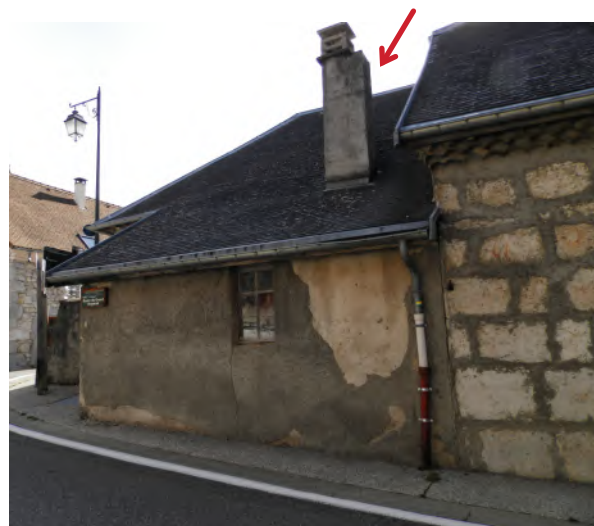
Le devenir du local chaufferie et de sa cheminée disgracieuse seront à étudier - démolition ?
