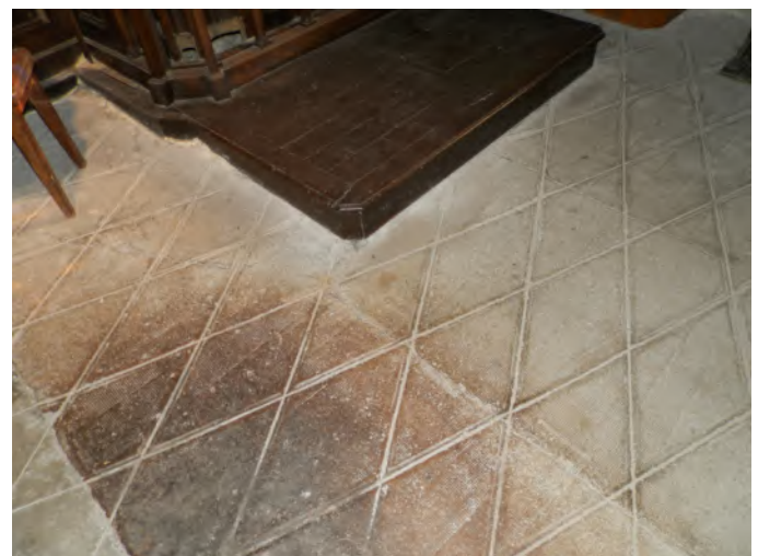
Sol en béton de ciment - chapelle Sud
