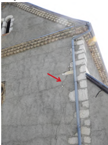
Ouverture du chaînage d'angle Sud-Ouest
