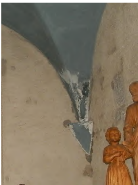
Présence importante de sels et pourrissement Clocher
