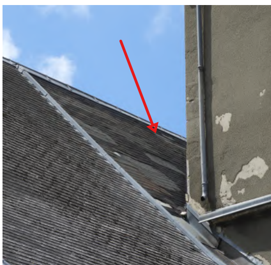
Situation de la zone de bâchage sur le pan Nord de l'église au droit du clocher
