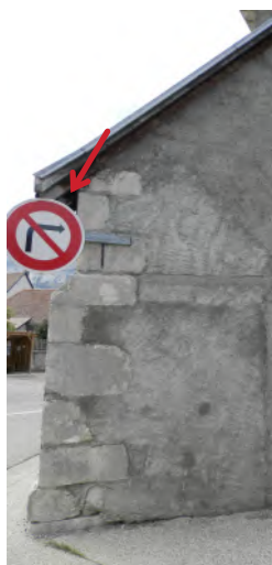
Panneau de signalisation sur contrefort Élément fortement dissonant
