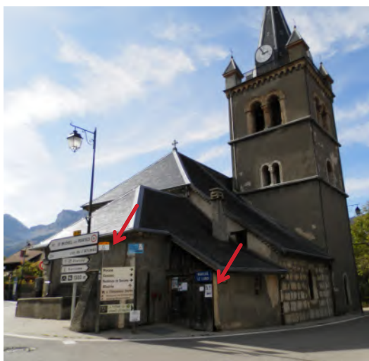
Panneaux de signalisations et lampadaire communal altèrent la vision du chevet de l'église
