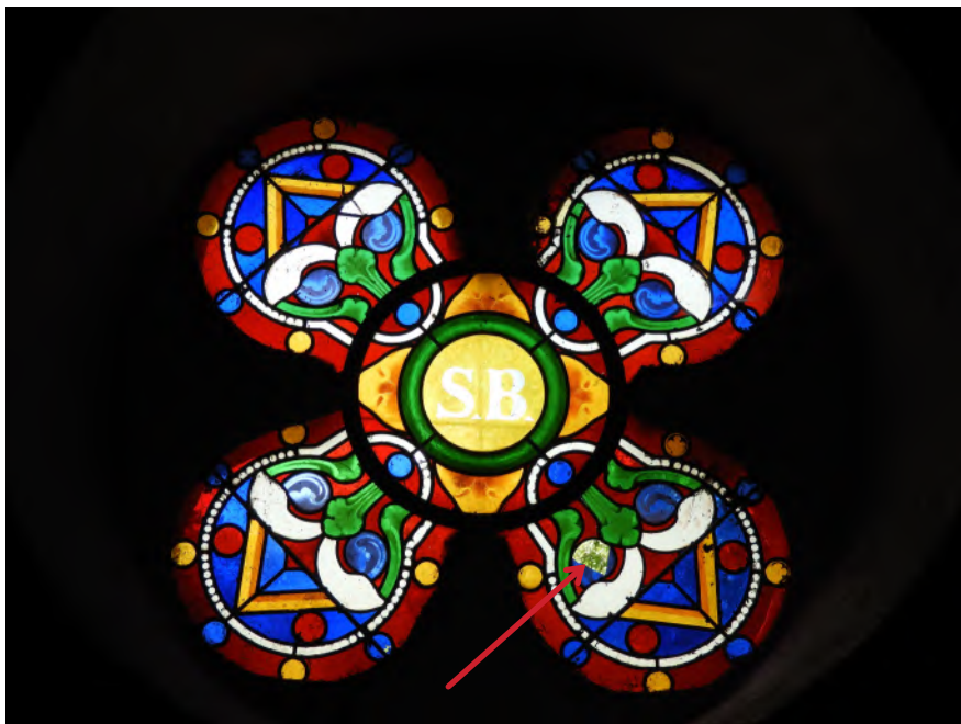
Quadrilobe - Verre manquant à remplacer
