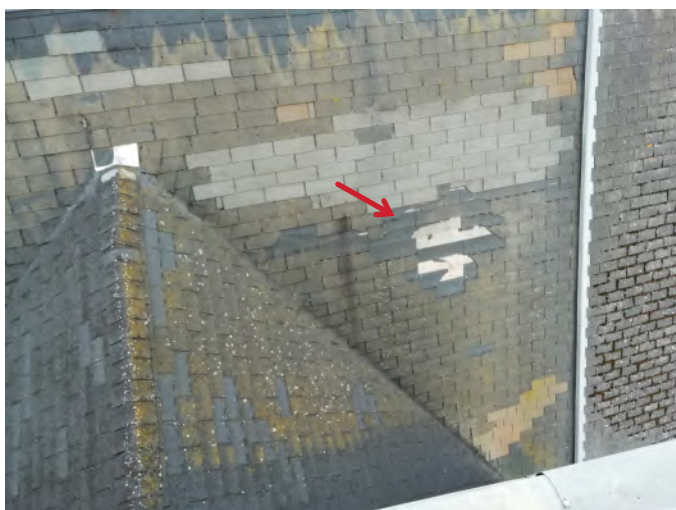
Couverture en bardeaux canadiens avant bâchage en janvier 2022
