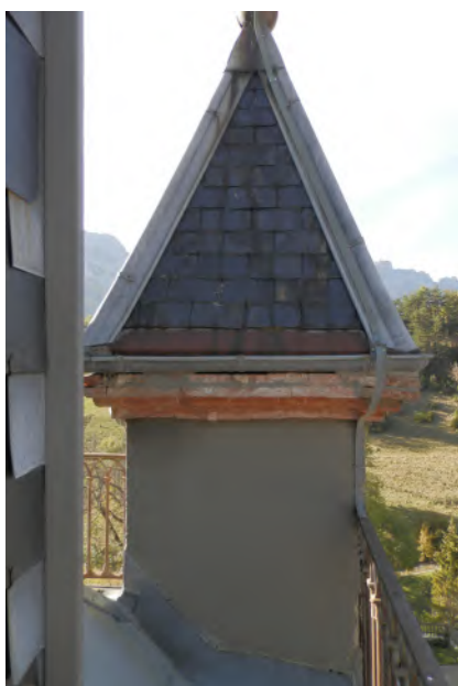
Vétusté des couvertures des clochetons
