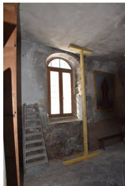
Etalement solivage sacristie
