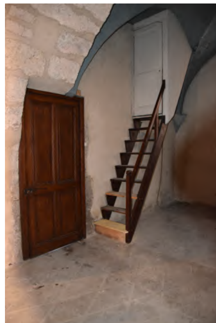
Consolidation escalier du clocher
