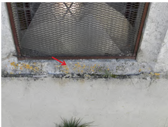
Elévation Nord - microvégétaux allège baie
