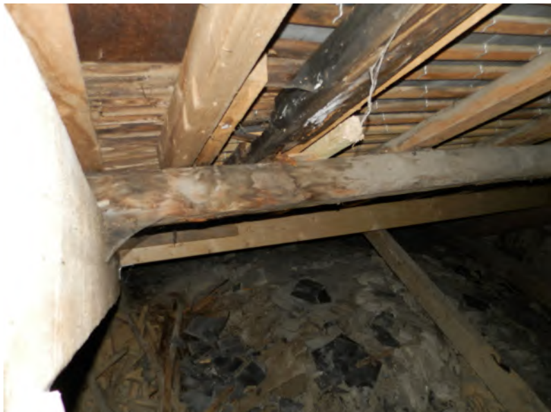
Remplacement de la panne au dessus de la chapelle Nord
