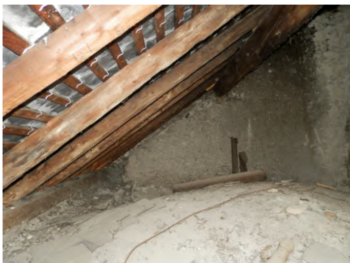
Chapelle Sud - bois de charpente relativement sains
