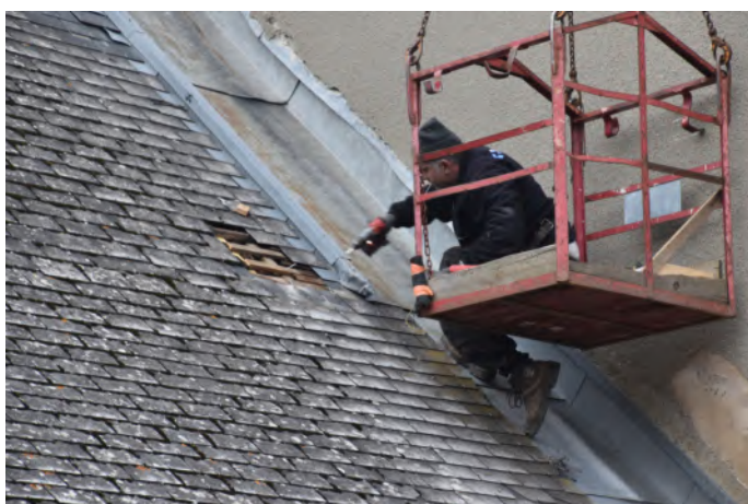
Remplacement ponctuel d'ardoises
