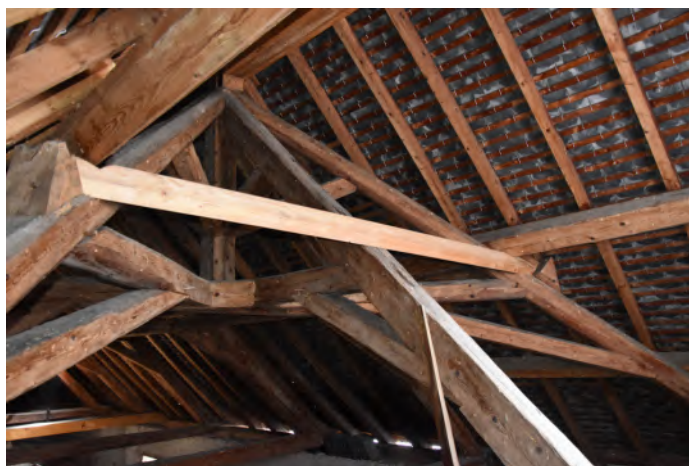
Pose d'une panne de consolidation des 3 demi-fermes
