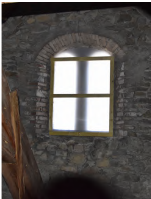
Baie axiale du comble fermée
