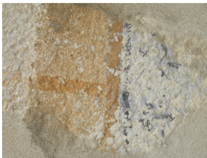
Polychromie très lacunaire sur le cintre en pierre de taille du porche : décors de faux appareillage et de filets de teinte ocre et noire
